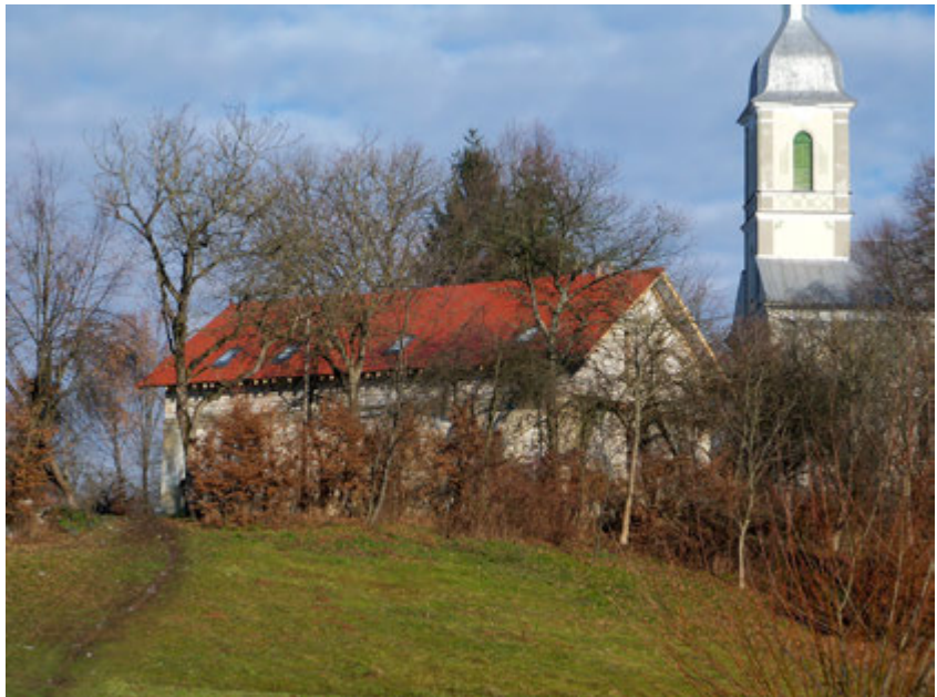
Foto: Ein dichtes Dach auf dem zukünftigen Jugendgästehaus. Zum Glück spielt auch das Wetter mit!
